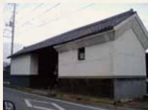
⑥ 田安陣屋長屋門
